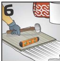
6 Golpear las losetas con un mazo de hule levemente del centro de la loseta hacia afuera para sacar el aire y asegurar su contacto con el adhesivo. Verifique la correcta nivelación de las losetas.
